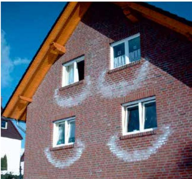
Ausblühungen (hier im Bild die sogenannten „Wassersäcke“), entstanden durch Regenwasser, das durch nicht fachgerecht ausgeführte Fensterbänke in das Mauerwerk eingedrungen ist.
