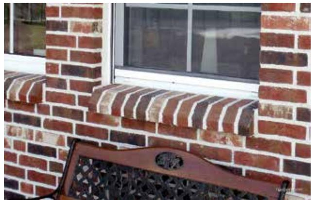
Beispiel für eine Fensterbank-Rollschicht mit Wärmedämmung
