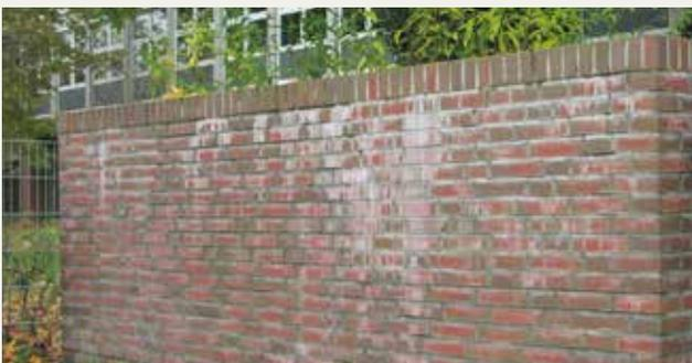
So bitte nicht: Die Oberkante dieser Mauer wurde manuell erstellt. Die Folge: Regenwasser dringt ins Mauerwerk ein und verursacht hässliche Auslaugungen. Mit einer vorgefertigten Mauerwerksabdeckung von Röben wäre das nicht passiert.
