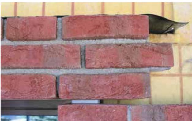
Läufersturz mit direktem Auflager und Verzahnung im Mauerwerksverband.
